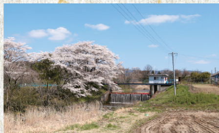
▲西根上堰の芝堤頭首工
